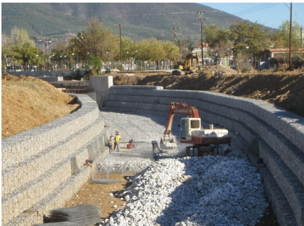
Σχ. 1.14 Ενδεικτική απεικόνιση διευθέτησης ρέματος με χρήση συρματοκιβωτίων
