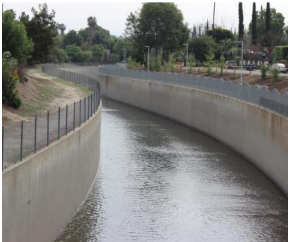
Σχ. 1.11 Ενδεικτική απεικόνιση διευθέτησης ρέματος με χρήση οπλισμένου σκυροδέματος (Αντεστραμμένο Π)
